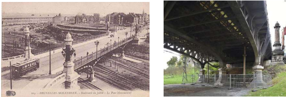
Fig. 2. Boulevard du Jubilé bridge (left : original, right today)
