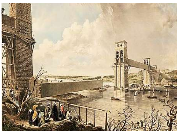
Фиг. 26: Монтиране на тръбната греда на моста Британия
