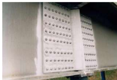
Фиг.14. Външен изглед на стеблото с пукнатина в главната греда в мостовата конструкция
