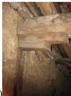
Фиг. 5.2а,б. Закотвяне на столицата към външния зид по ос 1 при колона К1Б чрез стоманени шини, пристягане на пакета: столица и възглавница чрез болтови съединения
