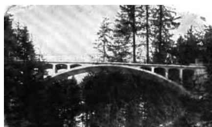
Фиг. 21. Мост на магистралата в Гунзесрид (Алгау) - Германия. Междуосие 32 м
