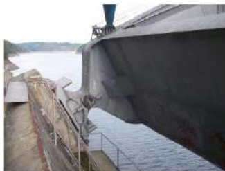
Фиг.11. Схема на ставното устройство Фиг.12. Изглед на ставата Фиг.13. Главна греда под ст.бет.плоча
